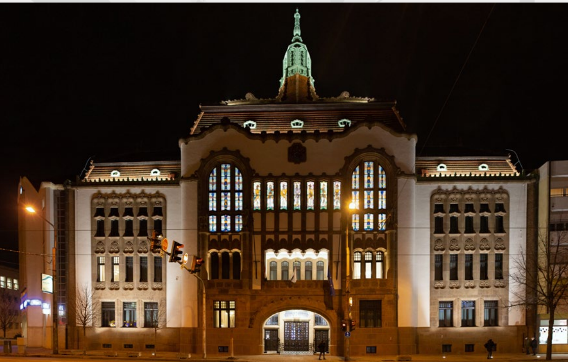
Vármegyeháza • Clădirea Consiliului Judeţean • County Hall
